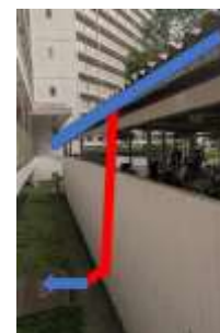
F棟自転車置場
