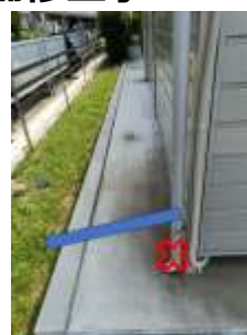
C棟バイク置場
