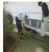
側溝作業風景
