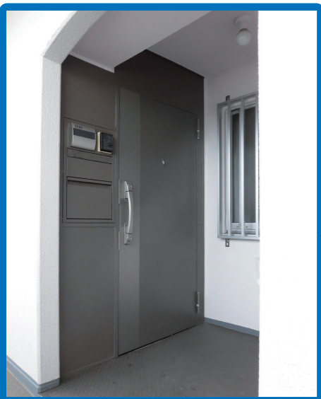
玄関Aタイプ(専用使用の共用部分)
