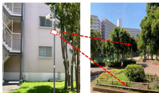
↑ 建物システム(東芝) 防犯カメラ
