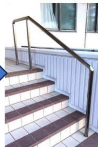
管理センター前 施工例
