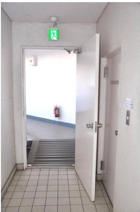
開放廊下の鉄扉
