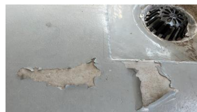
ベランダ床の表面に傷みがある
